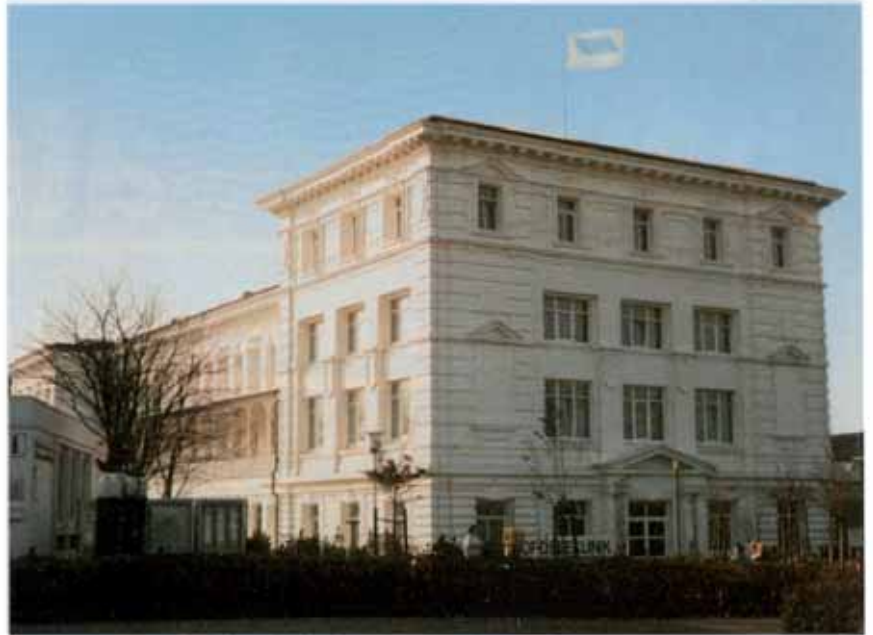
Nordseeklinik I (Hauptgebäude) Bülowallee 6
