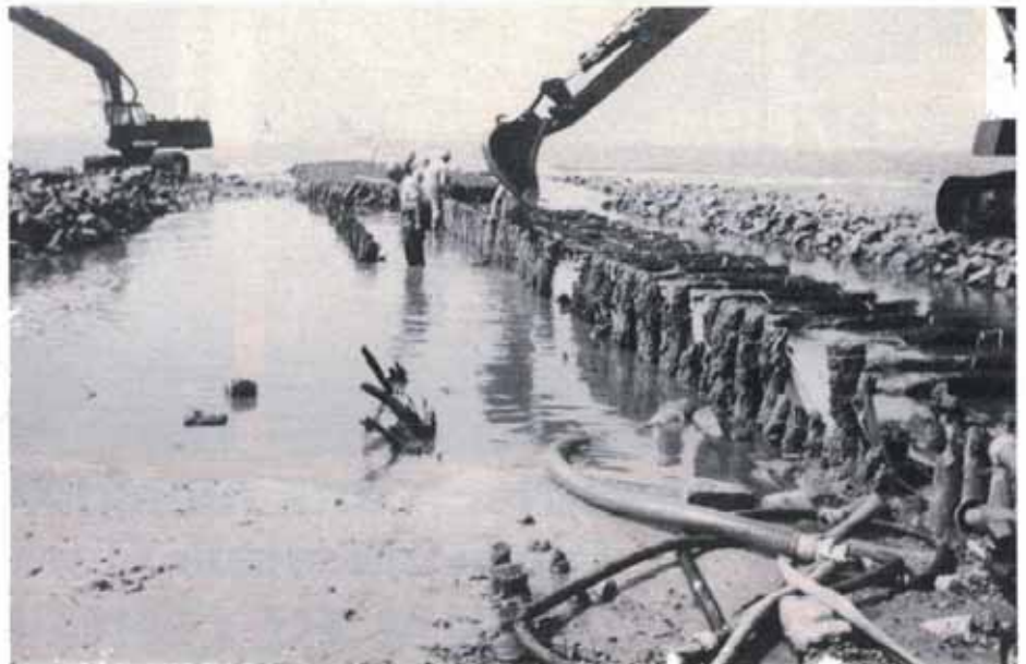
Einbau von Sinkstücken
