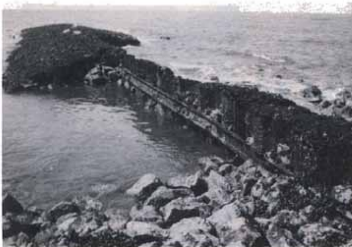
Schäden an der Buhne ZB1
