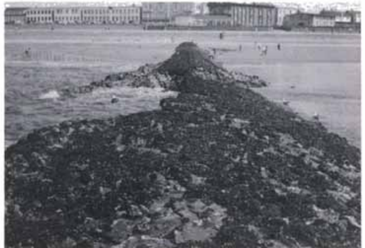
Schäden an der Buhne ZB1
