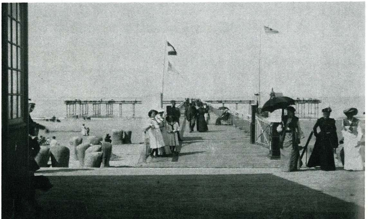
Blick auf den alten Seesteg Norderneys, einst eine Inselattraktion ersten Ranges. Die Reste des Bauwerks sind heute noch bei Niedrigwasser zu erkennen, Pfahlstümpfe, die aus dem Sandboden ragen.
